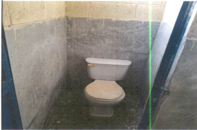
Foto 3: CAMBIO DE SANITARIOS
