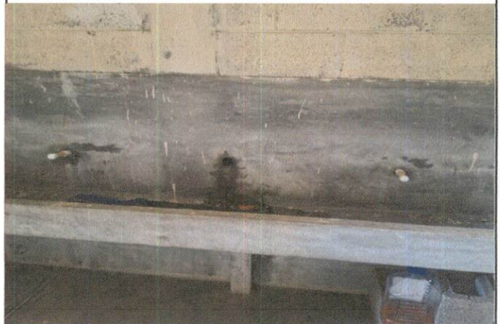
Foto 4: REMOZAMIENTO DE LAVAMANOS
